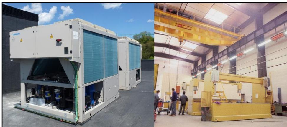
*Figura 1.3: Enfriadoras condensadas por aire e infrarrojos de gas, equipos que no requieren sala de máquinas*
