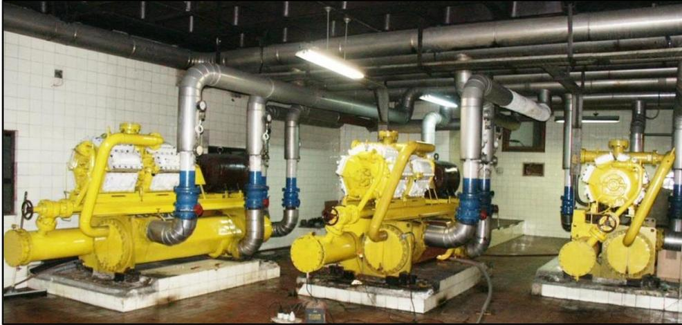
Figura 1.1: Sala de máquinas con enfriadoras condensadas por agua
