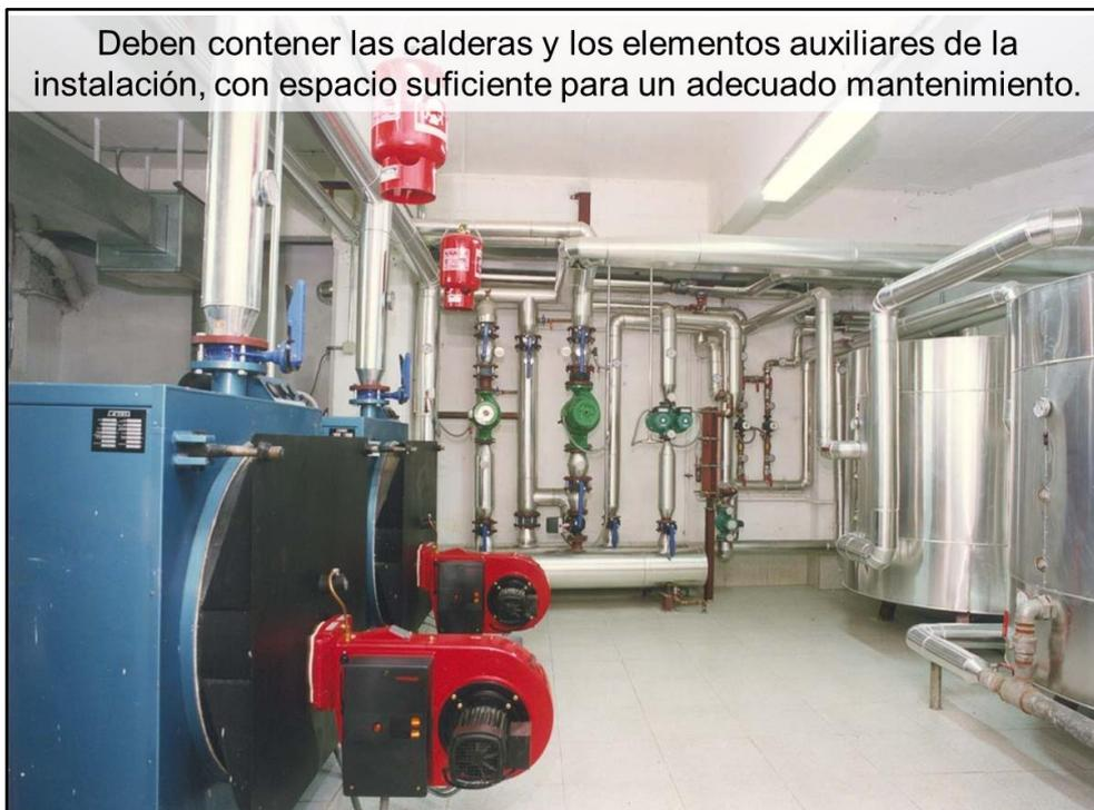
Figura 1.2: Sala de calderas con calderas de gasóleo, colectores y depósitos de agua caliente sanitaria
