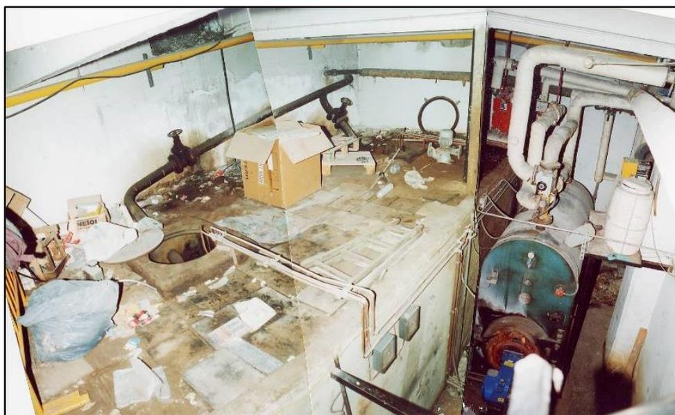
*Figura 1.4: Sala de calderas con depósito de gasóleo, paso de las tuberías de gas de otros usos, residuos y almacén, situación absolutamente INACEPTABLE*
